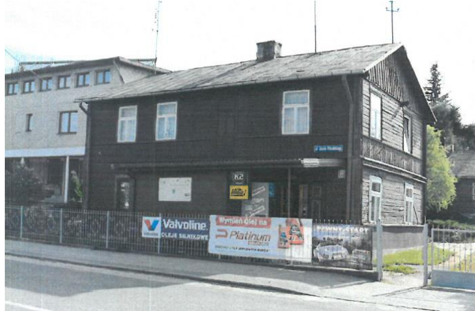
Zdjęcie 3 Drewniany dom ul. Piłsudskiego 26
