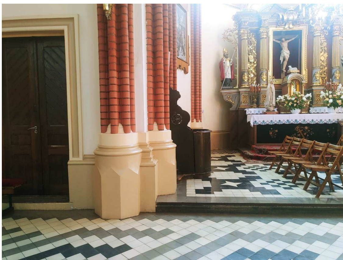
Fot. 19 Widok istniejącej posadzki
