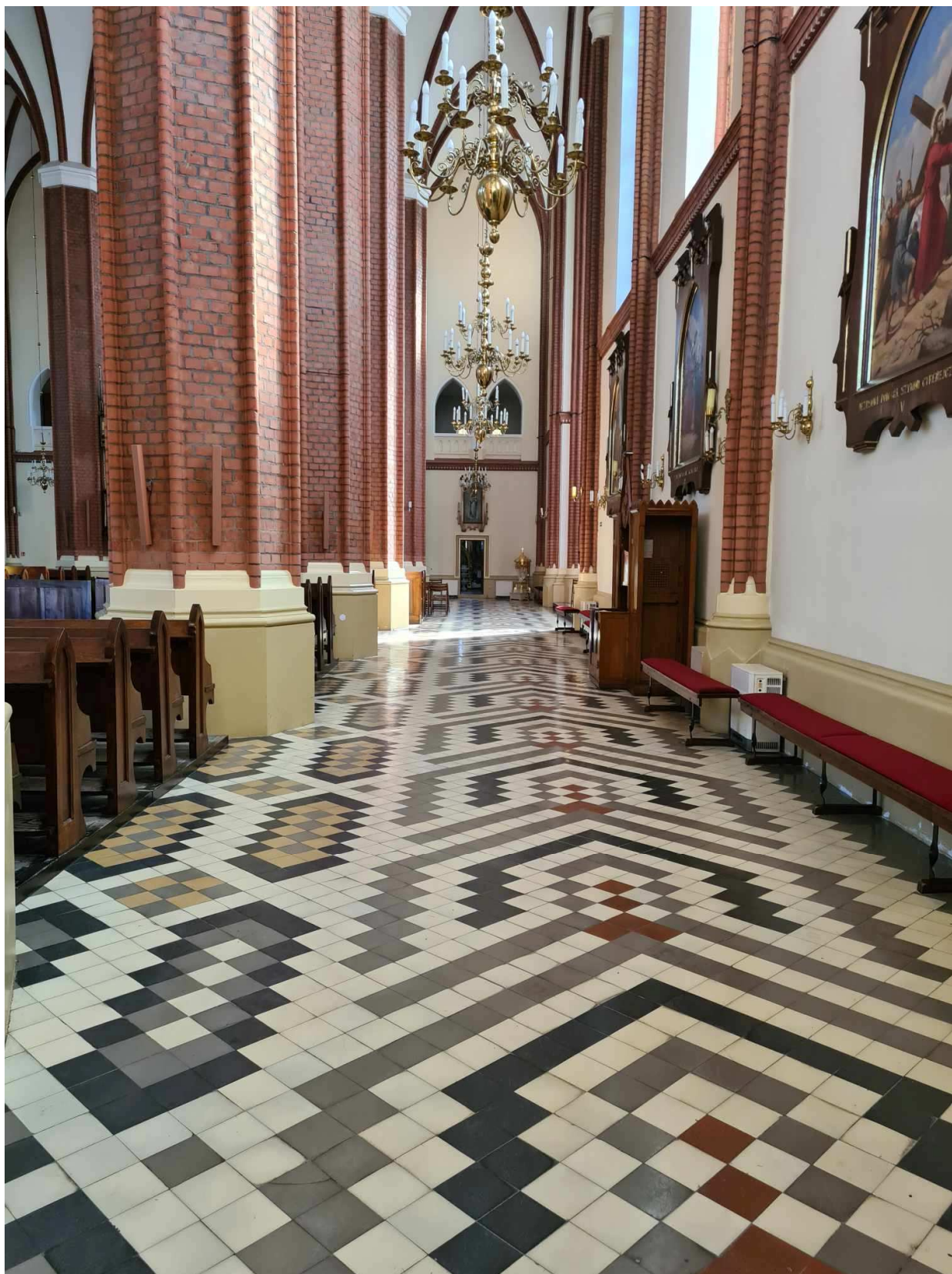
Fot. 11 Widok istniejącej posadzki
