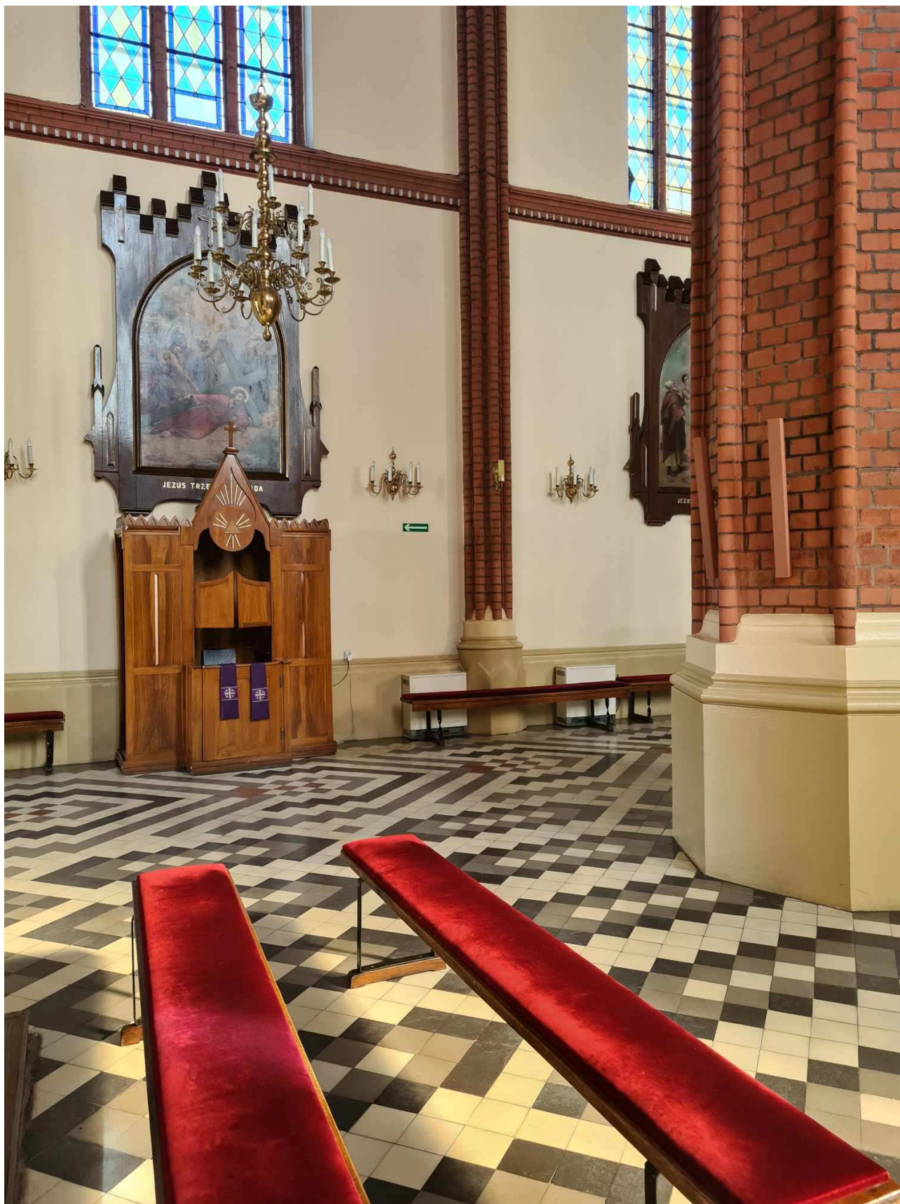
Fot. 17 Widok istniejącej posadzki
