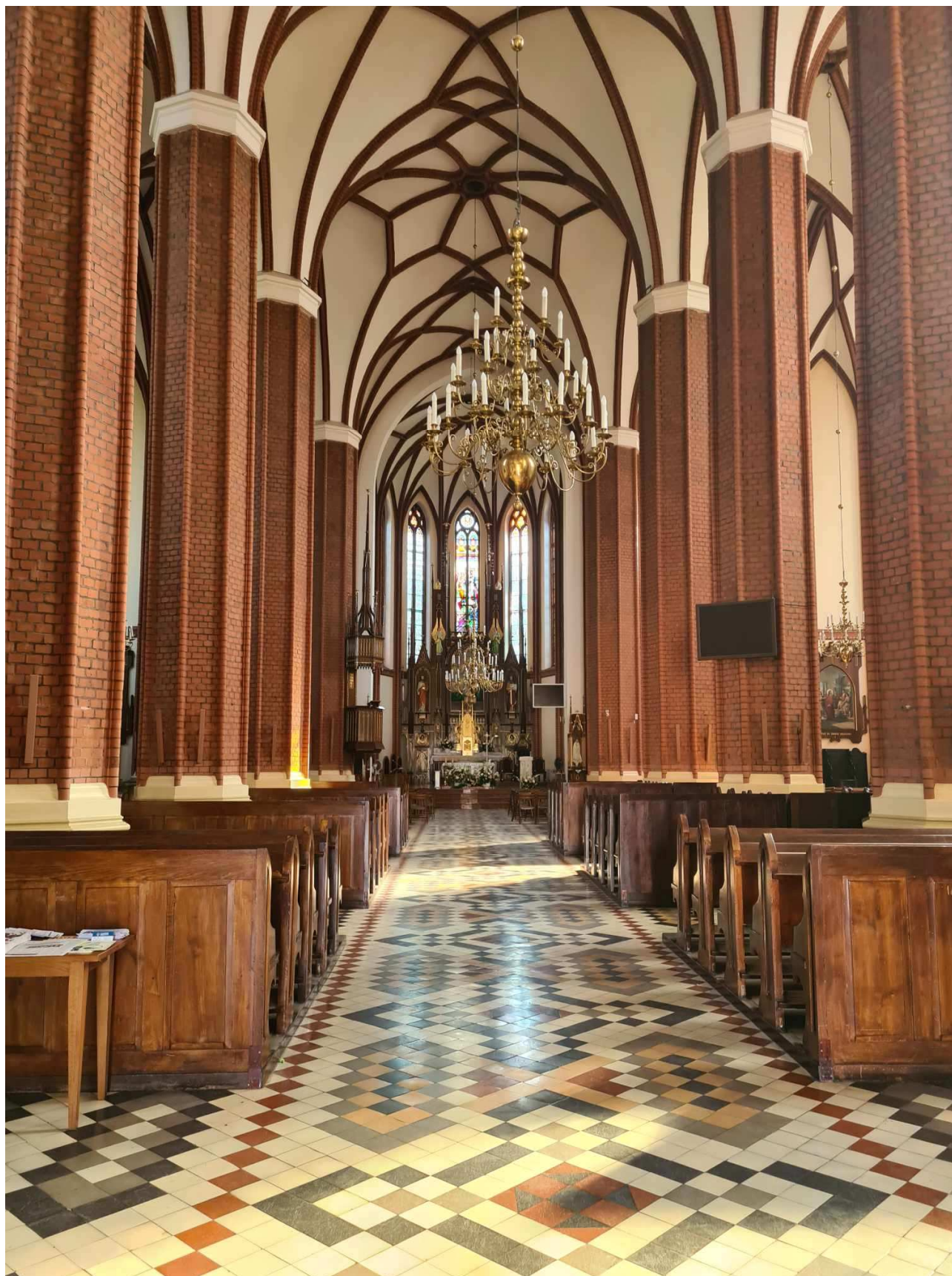
Fot. 13 Widok istniejącej posadzki
