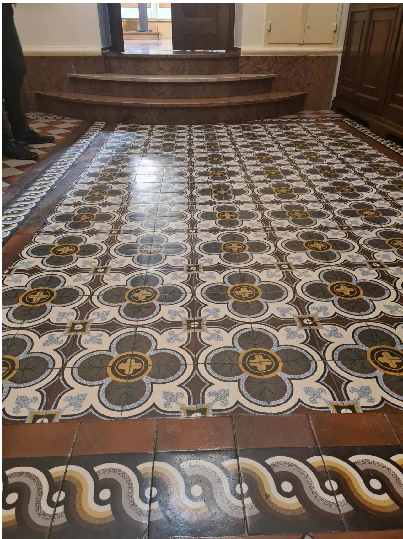
Fot. 14 Widok istniejącej posadzki w zakrysti
