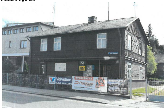
Zdjęcie 3 Drewniany dom ul. Piłsudskiego 26
