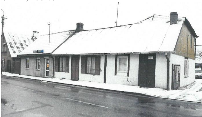
Zdjęcie 5 Drewniany dom ul. Wyzwolenia 5 i 7
