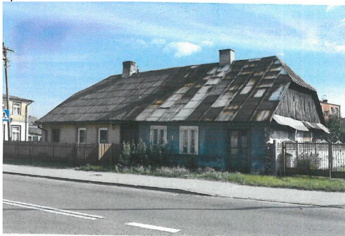
Zdjęcie 4 Drewniany dom ul. Wyzwolenia 17 i 19
